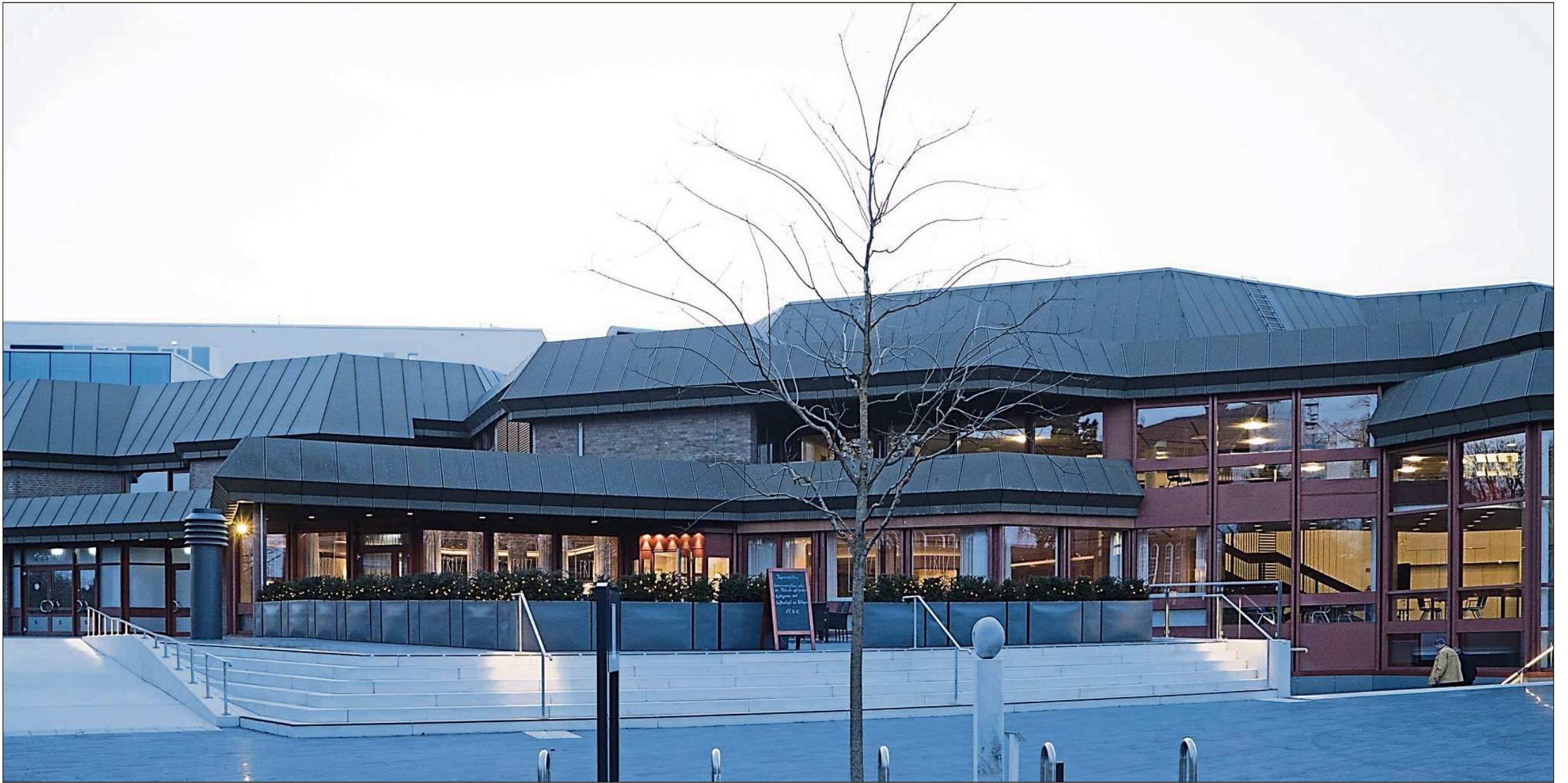
Die ausgeschriebenen Sanierungsarbeiten an einer Mehrzweckhalle landeten vor dem Europäischen Gerichtshof.
