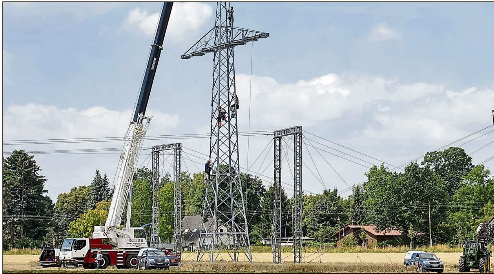
Wenn Stromtrassen gebaut werden, müssen Techniker zu den Masten und Leitungen fahren können.
